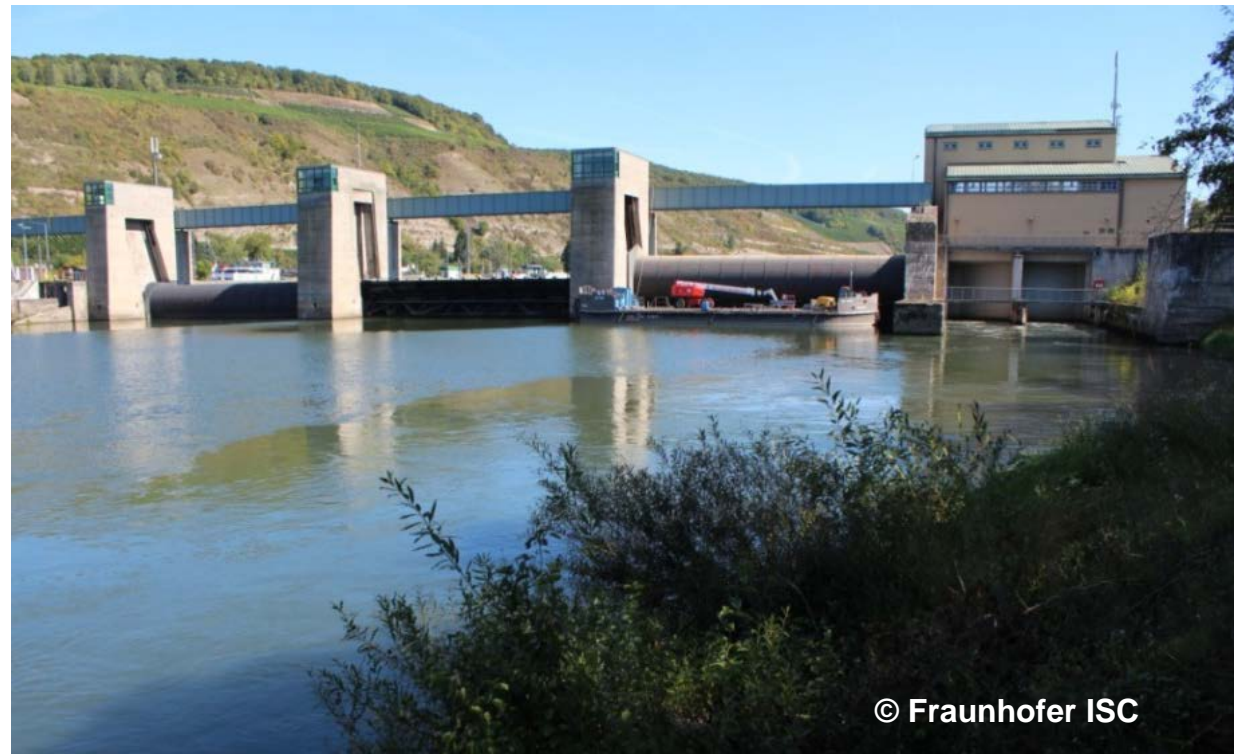
Mainschleuse Erlabrunn bei Würzburg mit 2,9 MW Wasserkraftwerk (Fallhöhe 4 m, E.ON Bayern)
